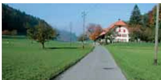
Verkehrssarme Nebenstrasse ohne Trottoir, Fuss- und Radweg
